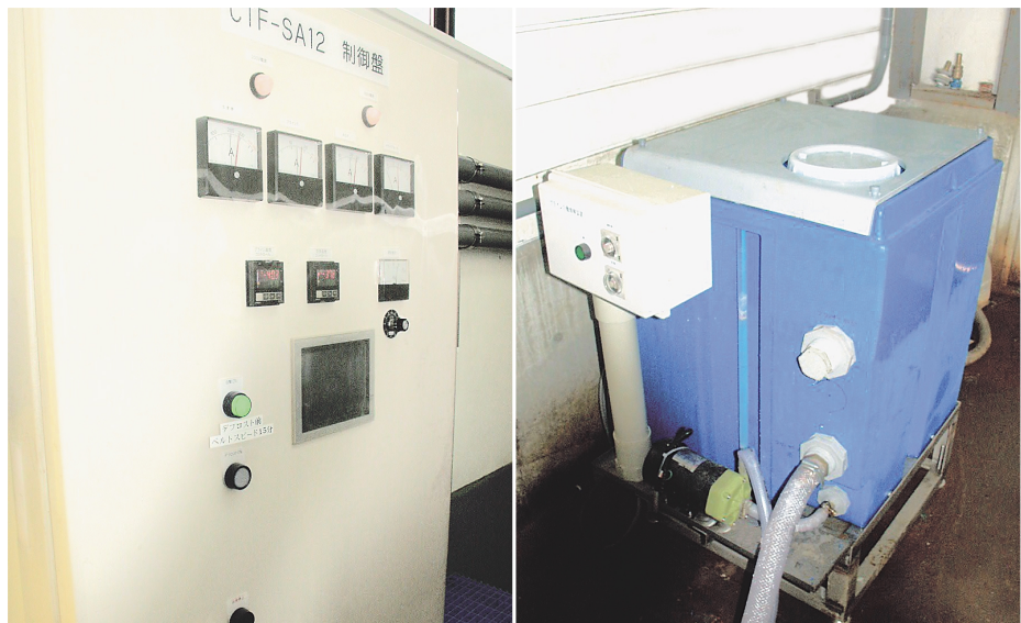
液晶タッチパネル採用で視認性・操作性が大幅に向上した制御盤
